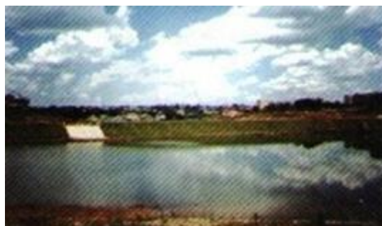
Figura 47: Bacia de retenção – N.A. permanente – Município de Uberaba Fonte: Canholi, 2005
