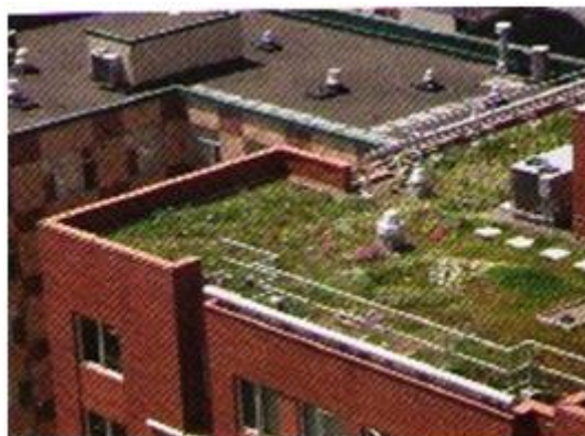
Figura 50: Telhado reservatório / telhado verde Fonte: Portland, 2002
