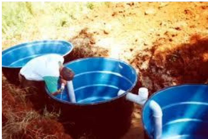
Figura 23: Fossa Séptica Fonte: Emater, 2014
