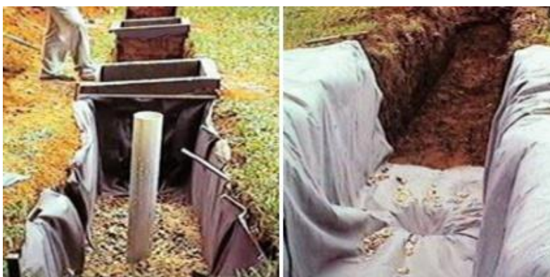
Figura 42: Exemplos de trincheira de infiltração Fonte: Collischonn, 2008
