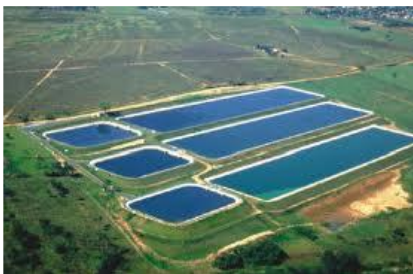
Figura 25: Lagoas de Estabilização Fonte: USP, 2014
